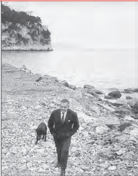
Le Prince Rainier III sur le terre-plein de Fontvieille en cours de construction
